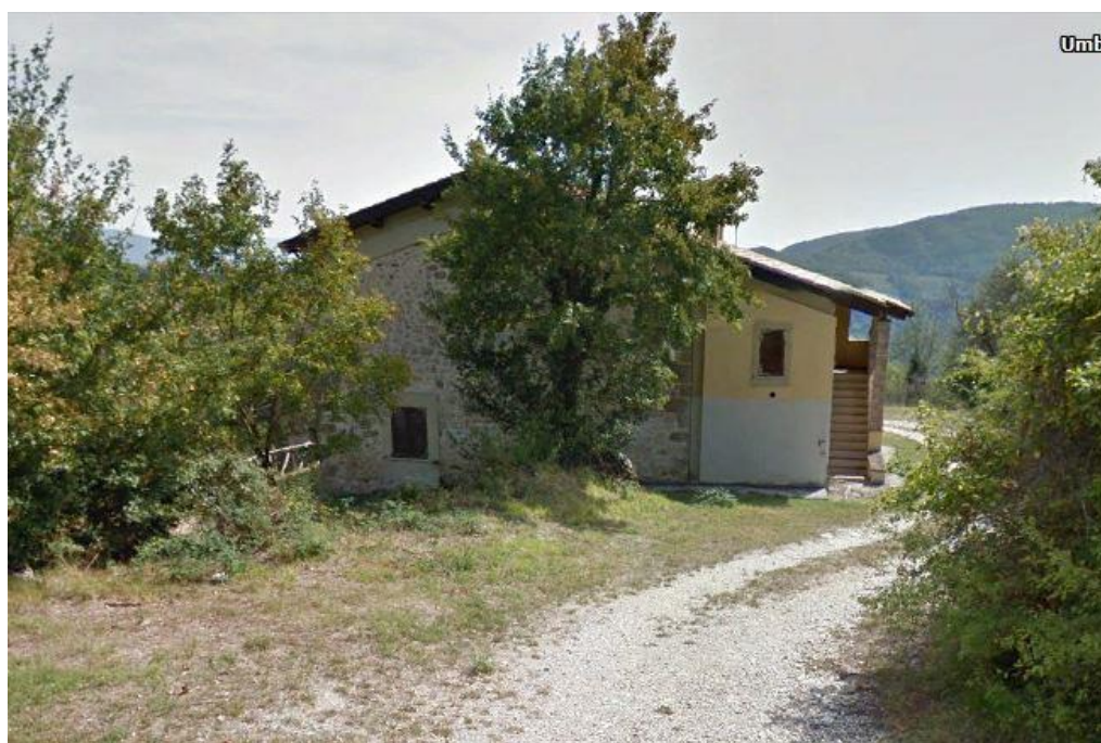
Figura 48. IDPT 146, Abitazione (SF 215C)
