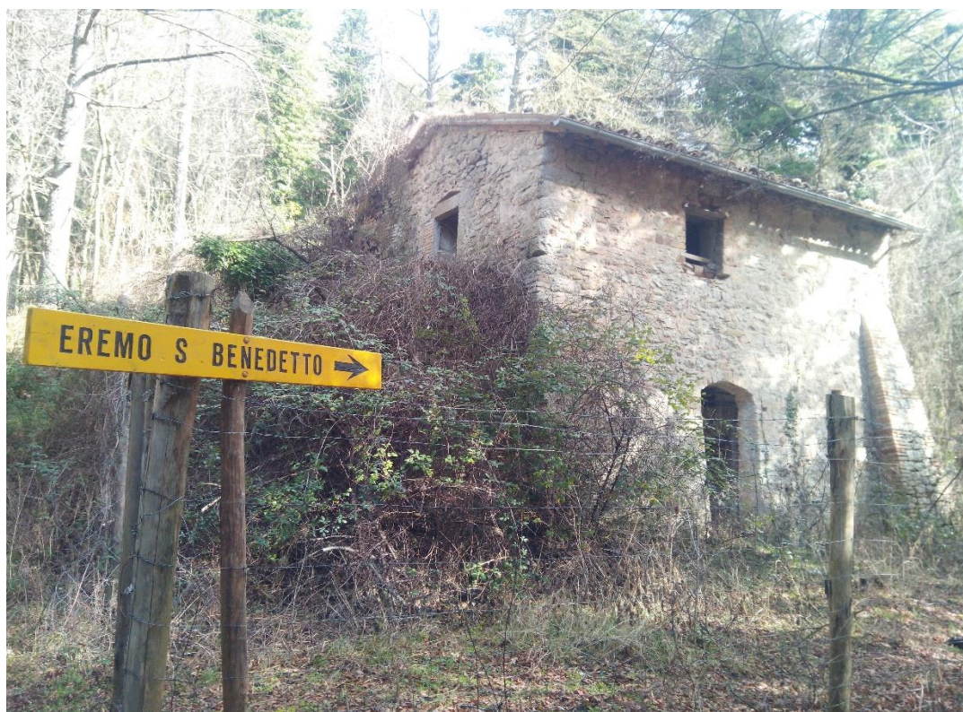
Figura 38. IDPT 95, Rudere con deposito limitrofo alla SF 49c
