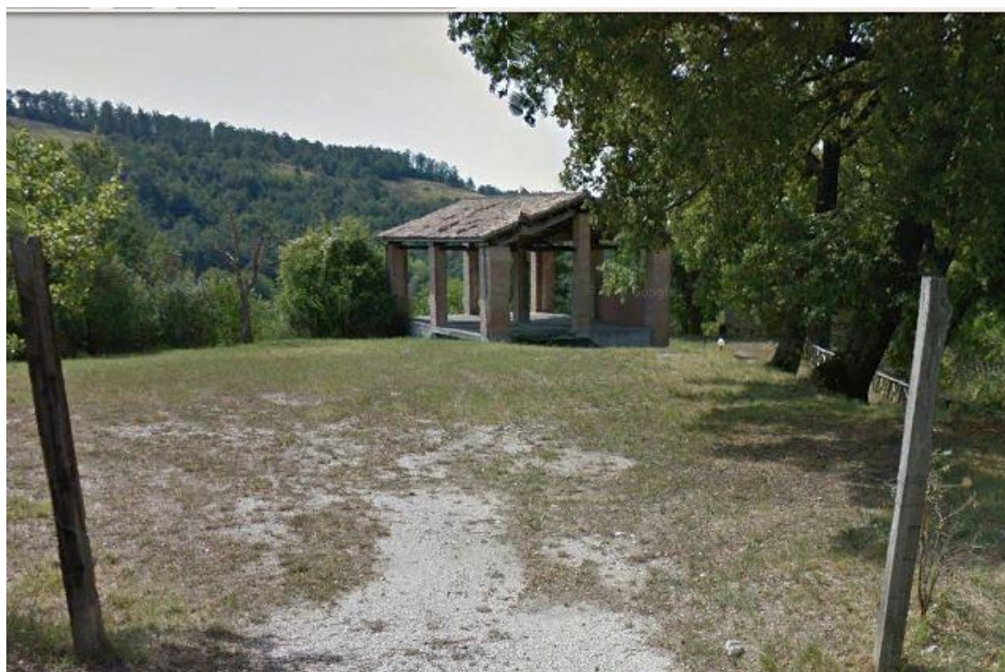
Figura 52. IDPT 151, Abitazione (SF 214C)
