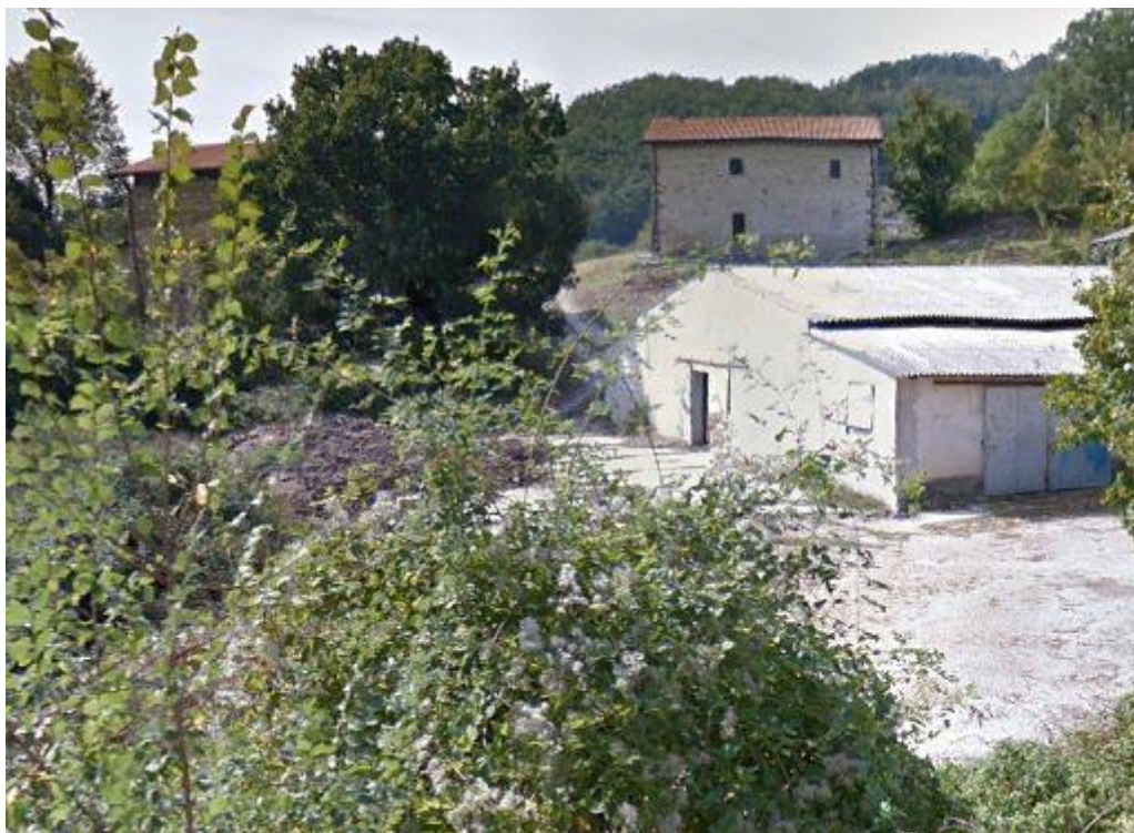
Figura 49. IDPT 147 E 148. Abitazione SF 215C
