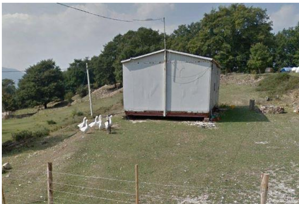
Figura 43. IDPT 117, Casetta prefabbricata (SF 221B)
